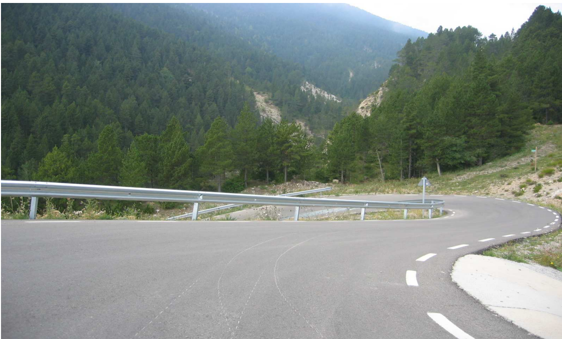
Sorpresitas finales del puerto. Rampas duras y mantenidas.
