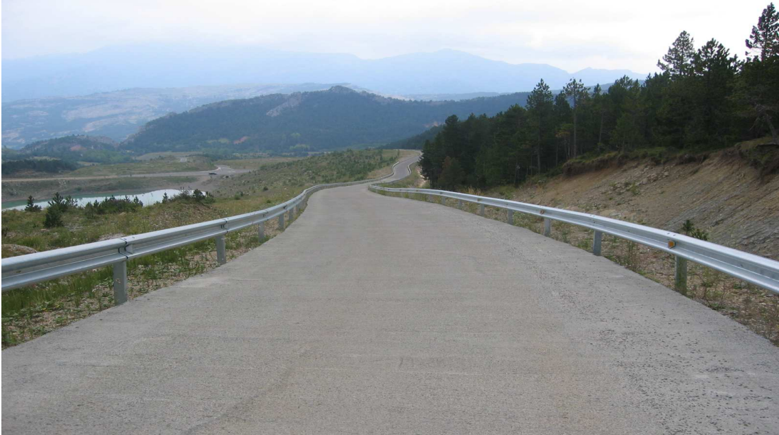
La misma rampa, pero vista desde la mitad. No se aprecia la pendiente real que hay.
